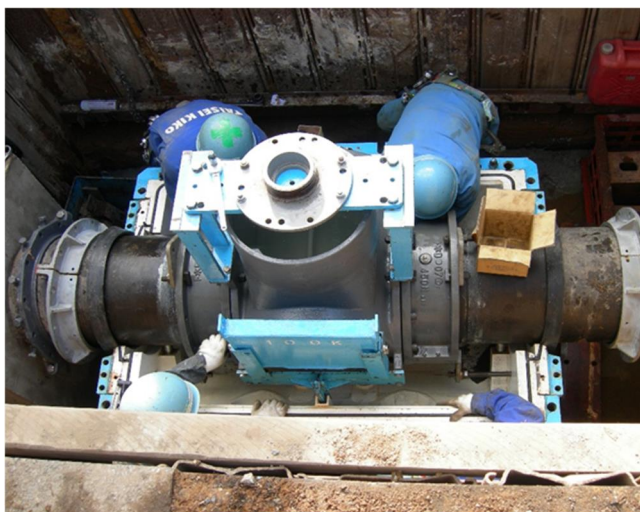
▲配水本管の整備
