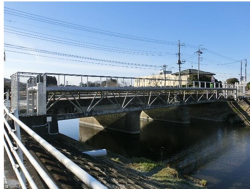
▲トラス補剛形式水管橋（芳賀町）
