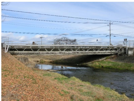
▲トラス補剛形式水管橋（芳賀町）
