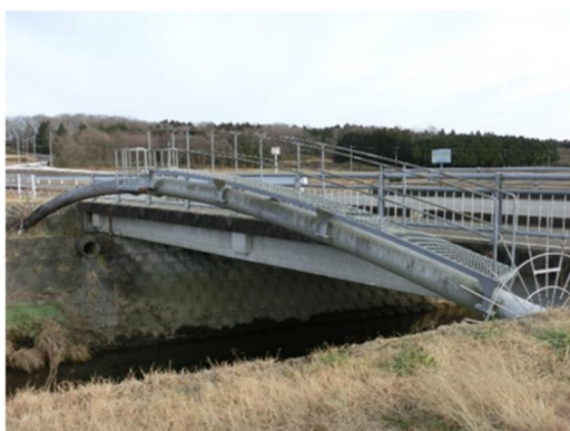
▲固定アーチ形式水管橋（芳賀町）
