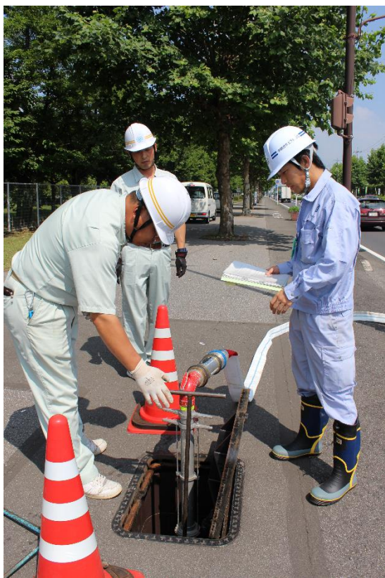
▲宇都宮芳賀緊急時連絡管運用訓練
