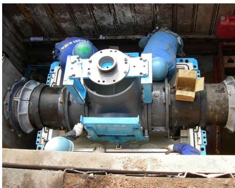
▲配水本管の整備
