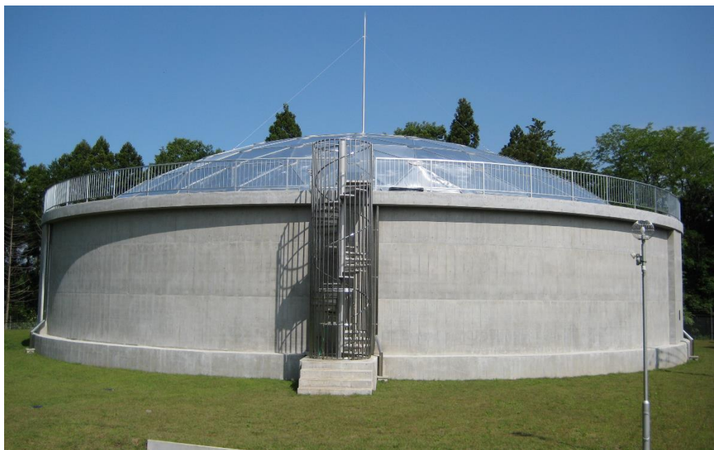
▲緊急遮断弁を設置した芳志戸第3配水池
