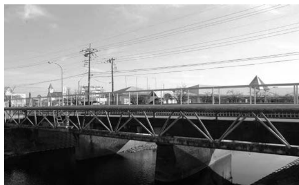
独立水管橋 芳賀町 五行川 五行橋
