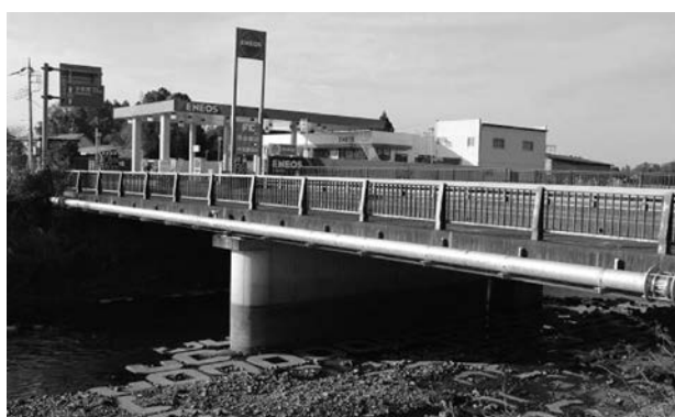
橋梁添架管 益子町 小貝川 紅取橋
