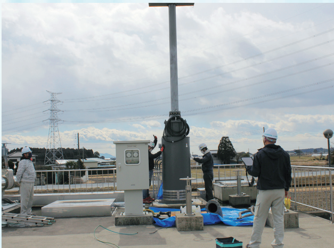
～芳志戸浄水場送水ポンプ交換工事～
