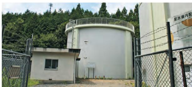
令和5年5月から実施していた益子配水池の改修工事では、主に配水池の外壁塗装と東側配水池の内面塗装、送水ポンプと運転制御機械の交換を行いました。
