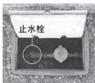
●蝶ねじタイプ(何回か回ります) 止水栓を右に止まるまで回します。
