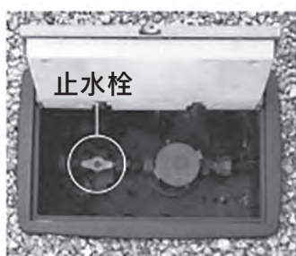
●90度の開閉するタイプ 止水栓を右に90度回します。▶閉まりました!
