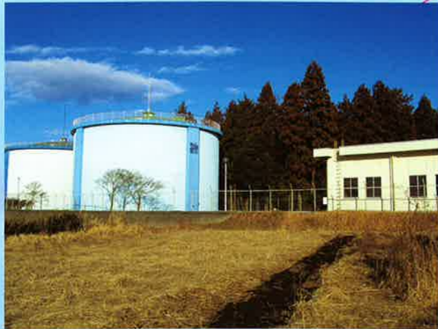
台町配水場 (PC 3,000m 3 × 2) ※県水受水 (3,000m 3 /日)
